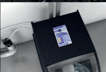
Das Touch-Farbdisplay der LEX Plus 10 Connect Anlagen führt durch die einfache Inbetriebnahme. Berührt man das Display, schaltet sich die Beleuchtung des Salztanks ein.
