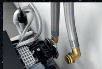
Die verwindungssicheren Steckverbindungen werden einfach auf die Verschneideeinheit gesteckt und mit Klammern fixiert – Undichtigkeiten werden so vermieden.
