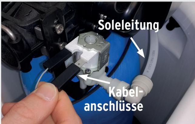
6. Verbinden Sie die Soleleitung und die Kabelanschlüsse mit dem Magnetventil.
