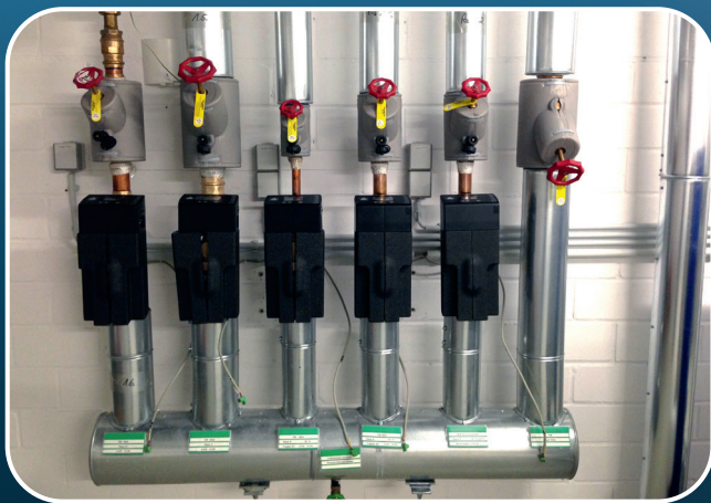
In dieser Großanlage werden einzelne Bereiche eines Großobjekts abgesichert und überwacht.
